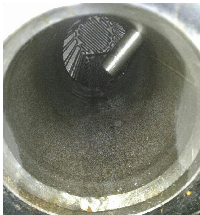
3 mois après – avec le traitement Vulcan Jusqu'à présent, la conduite installée n'a plus eu besoin d'être nettoyée.
