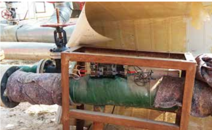
Avant d'installer Vulcan, la rouille et l'isolation des tuyaux ont été enlevées, et les bandes d'impulsion ont été enroulées sur le tuyau. Ensuite, l'isolation extérieure a été remise en place.
