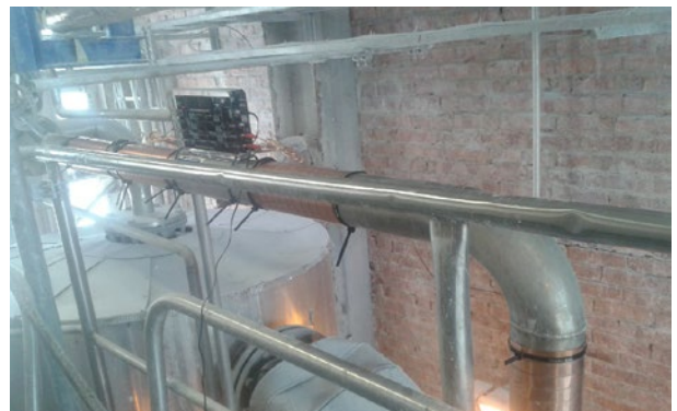
Installation de Vulcan S100 sur le four à chaux
